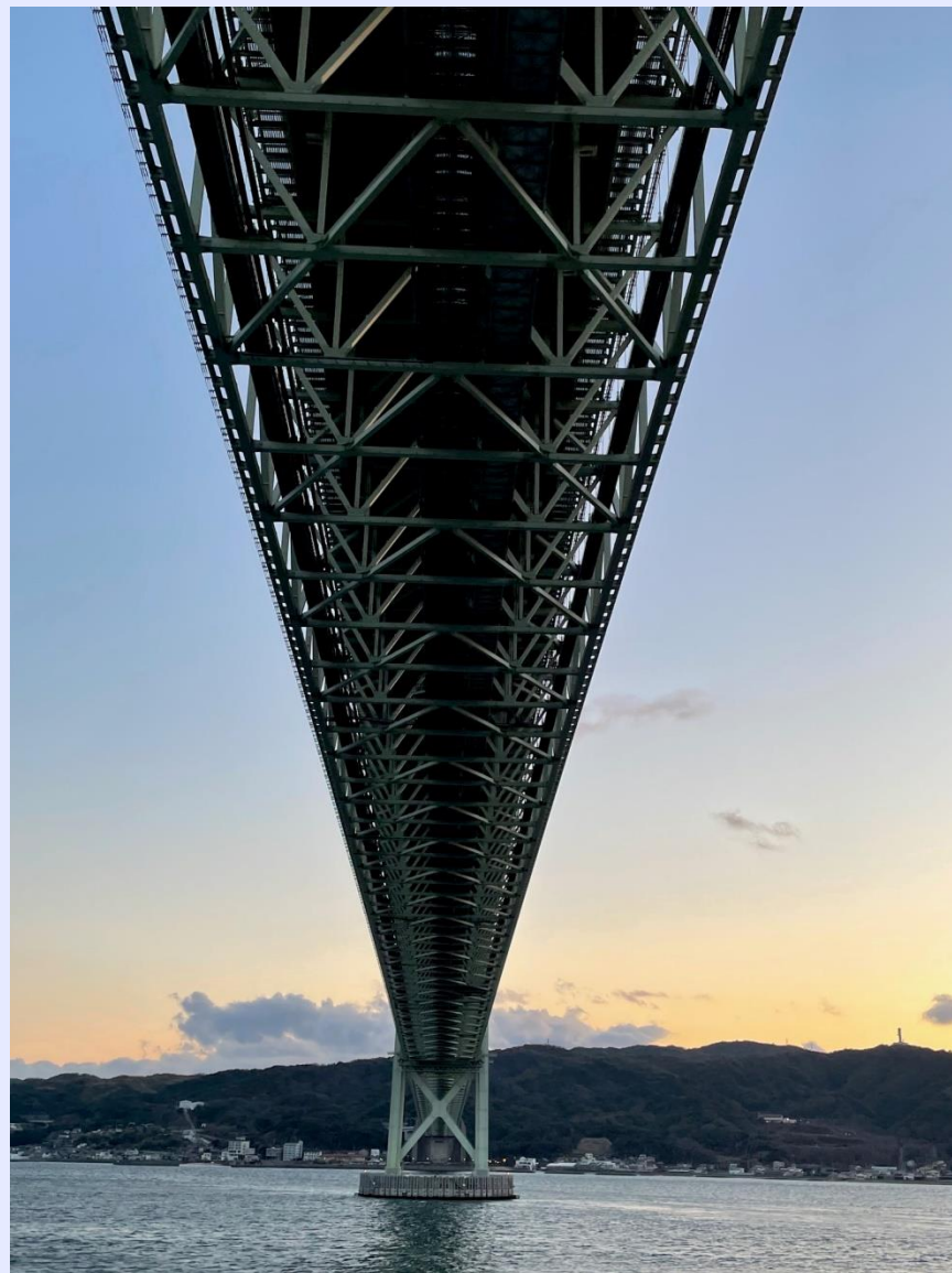
明石海峡大橋2
