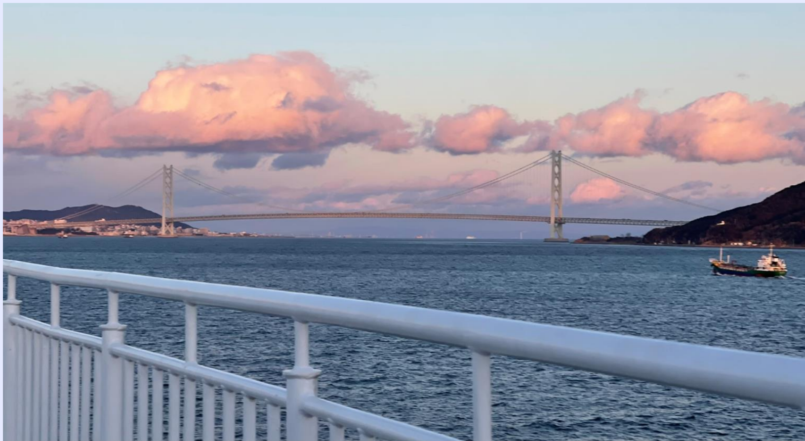
明石海峡大橋1
