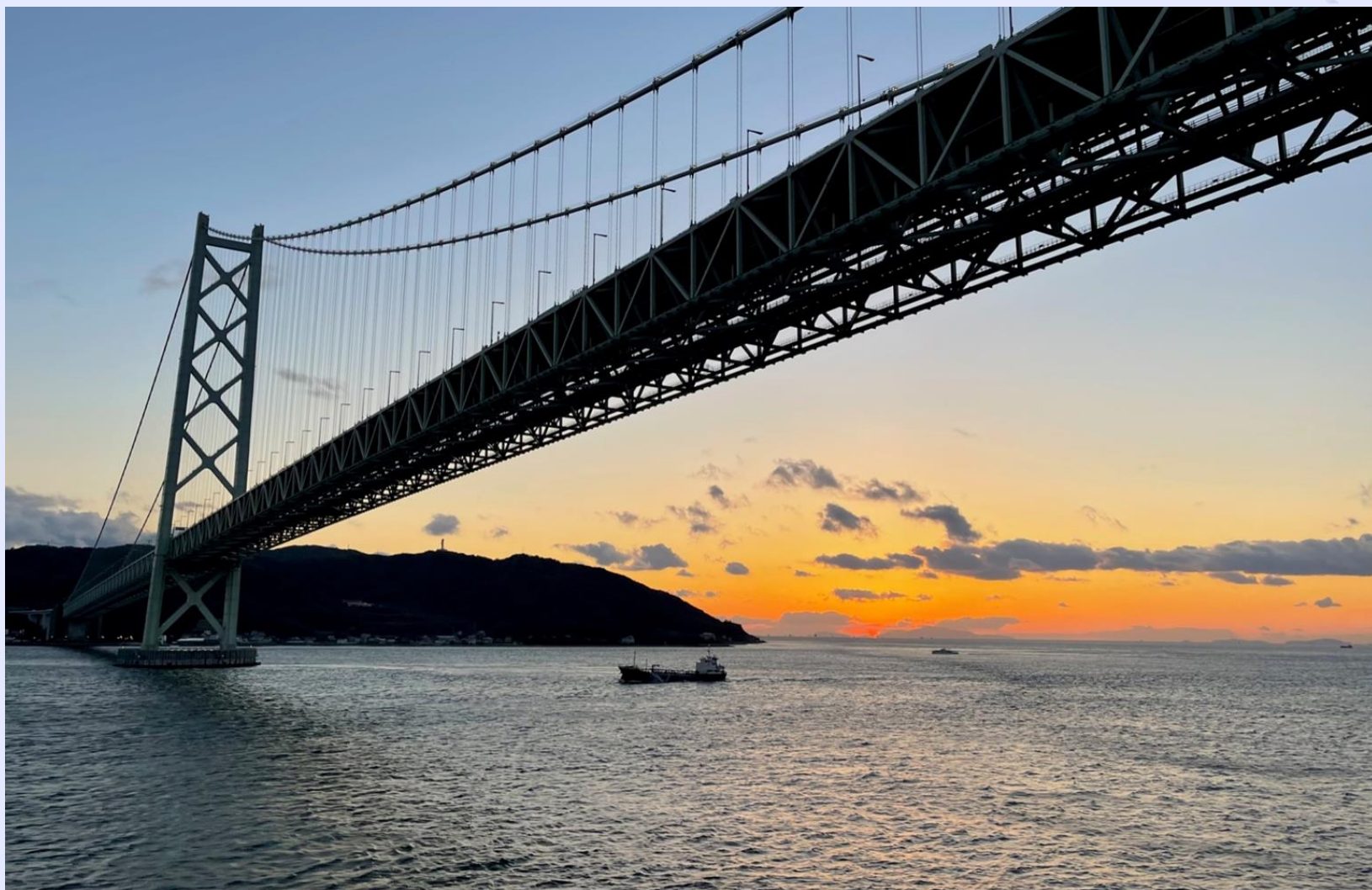
明石海峡大橋3
