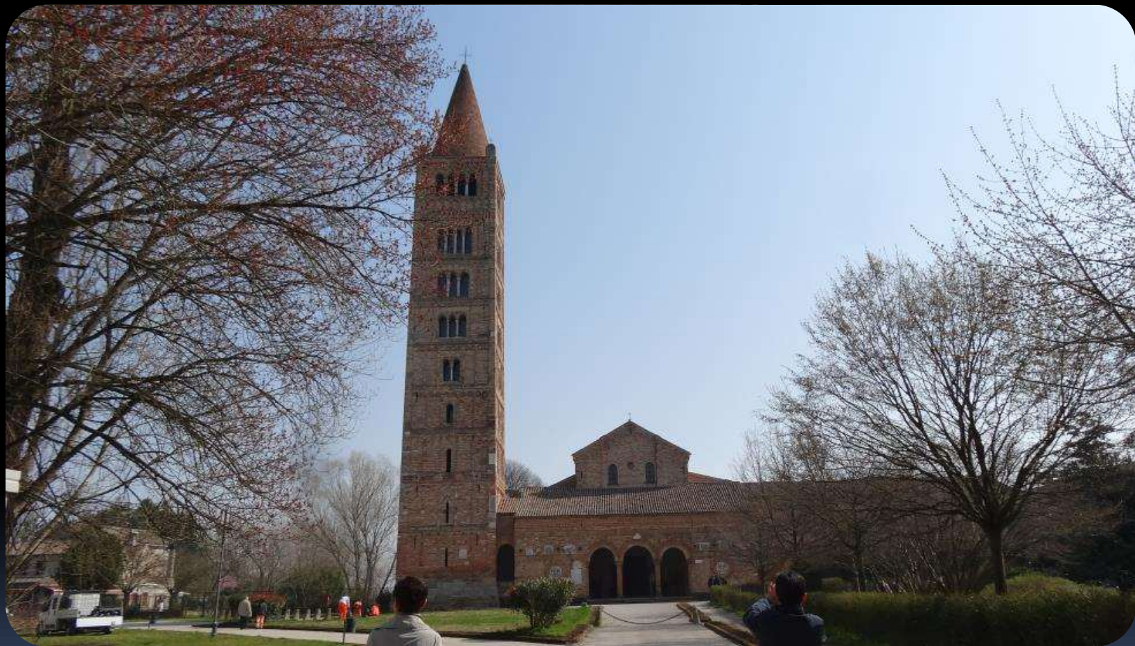
5-③ポンポーザの僧院ロマネスク鐘楼09
