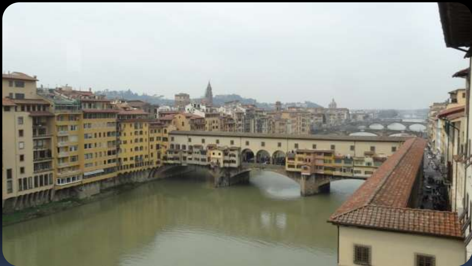
6-④ヴェッキオ橋04
