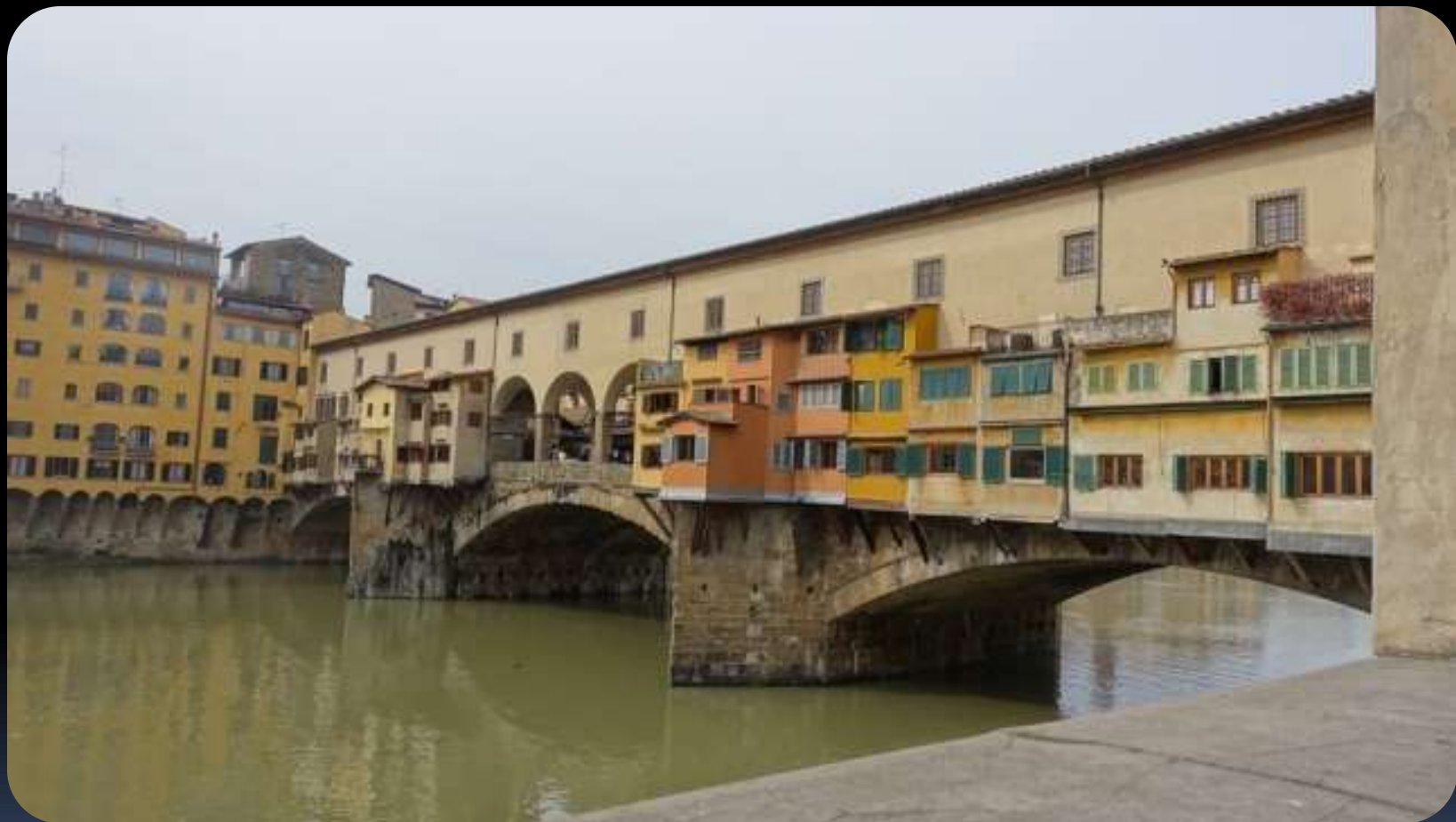
6-④ヴェッキオ橋01
