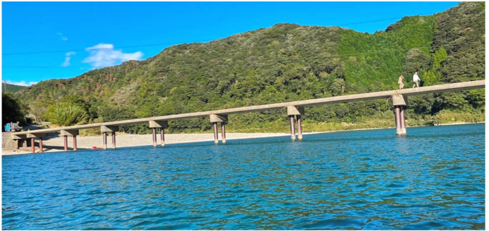
08四万十川03沈下橋
