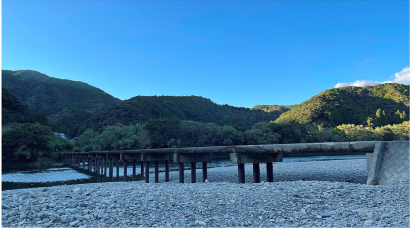
08四万十川07勝間沈下橋
