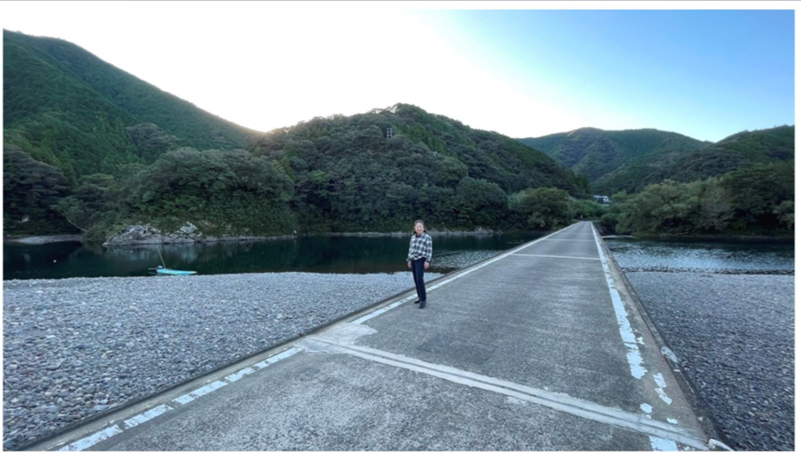
08四万十川08勝馬沈下橋
